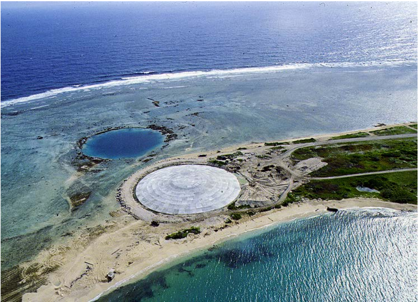
Luftbild des Runit Dome. Ein Anstieg des Meeresspiegels könnte die kleine Insel überfluten.
