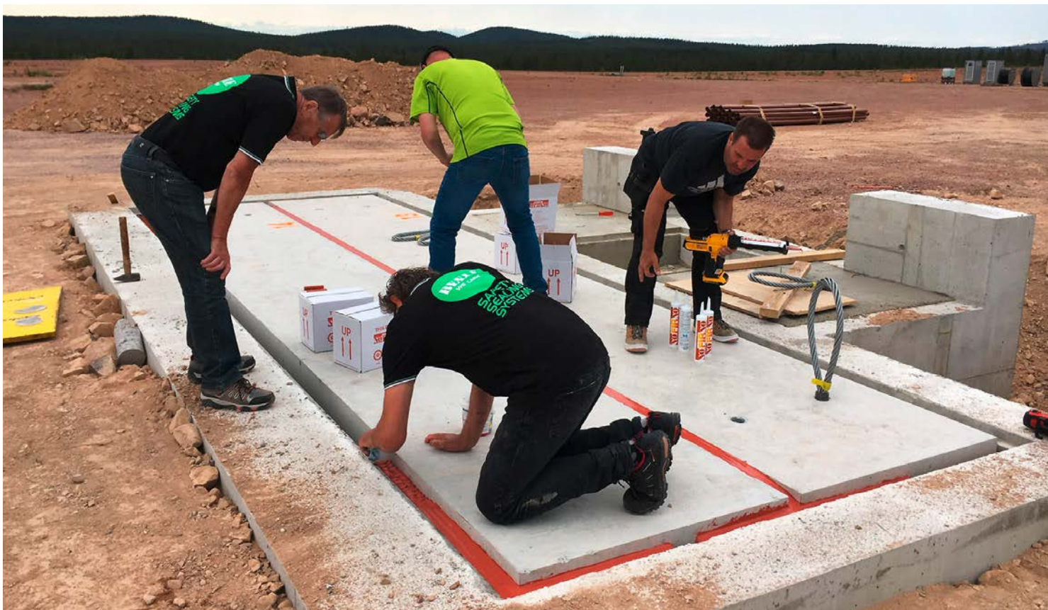
ill. 2: Étanchéification des joints.
